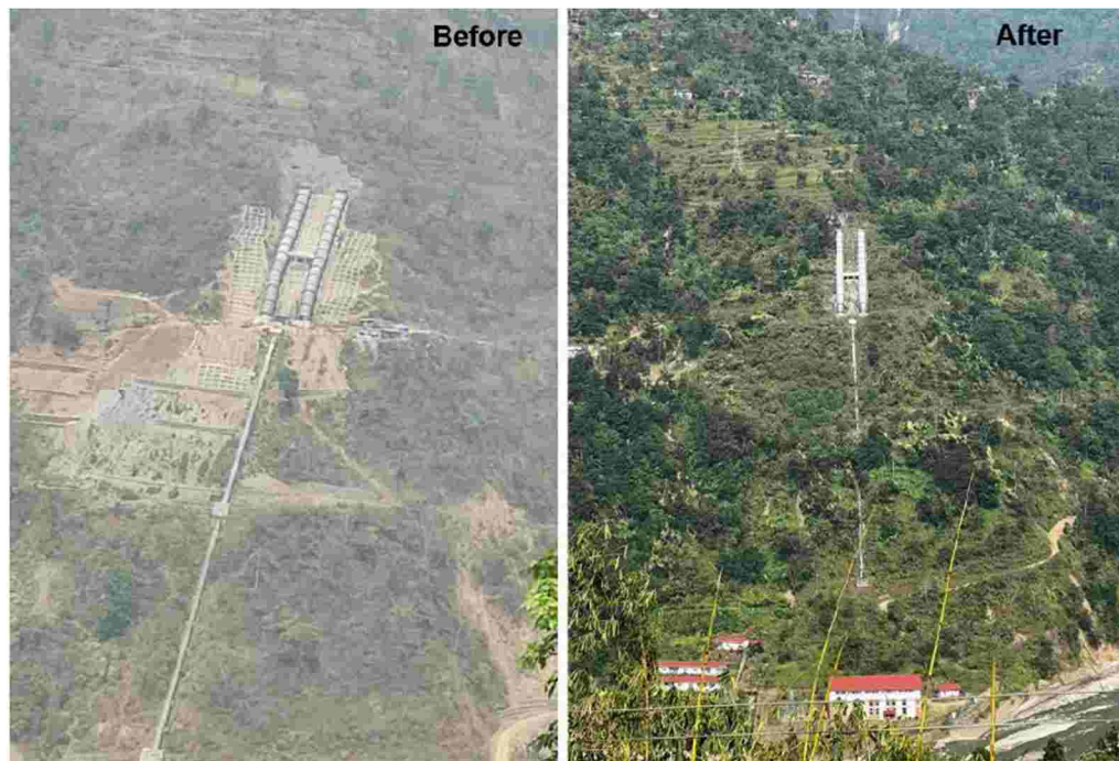
図 12-18 東ネパールイルラム県のマイベニ水力発電所水圧管路斜面の斜面安定工 28)
