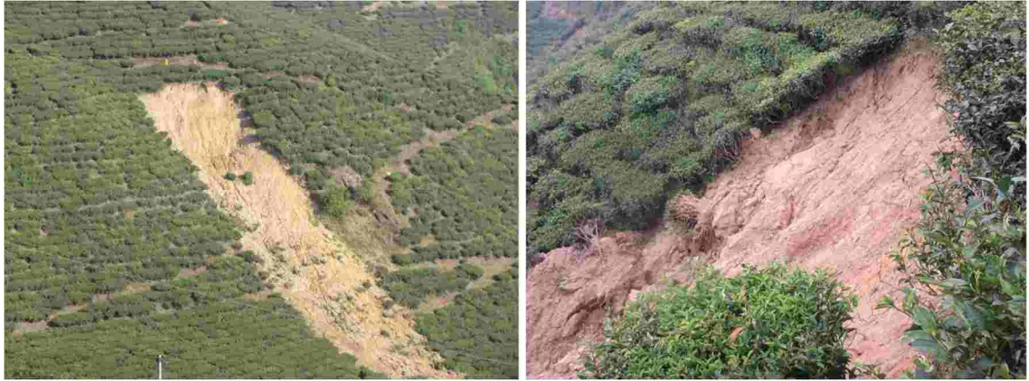
図 11-34 2025 年 10 月 4 日～5 日の豪雨による茶園の崩壊跡
