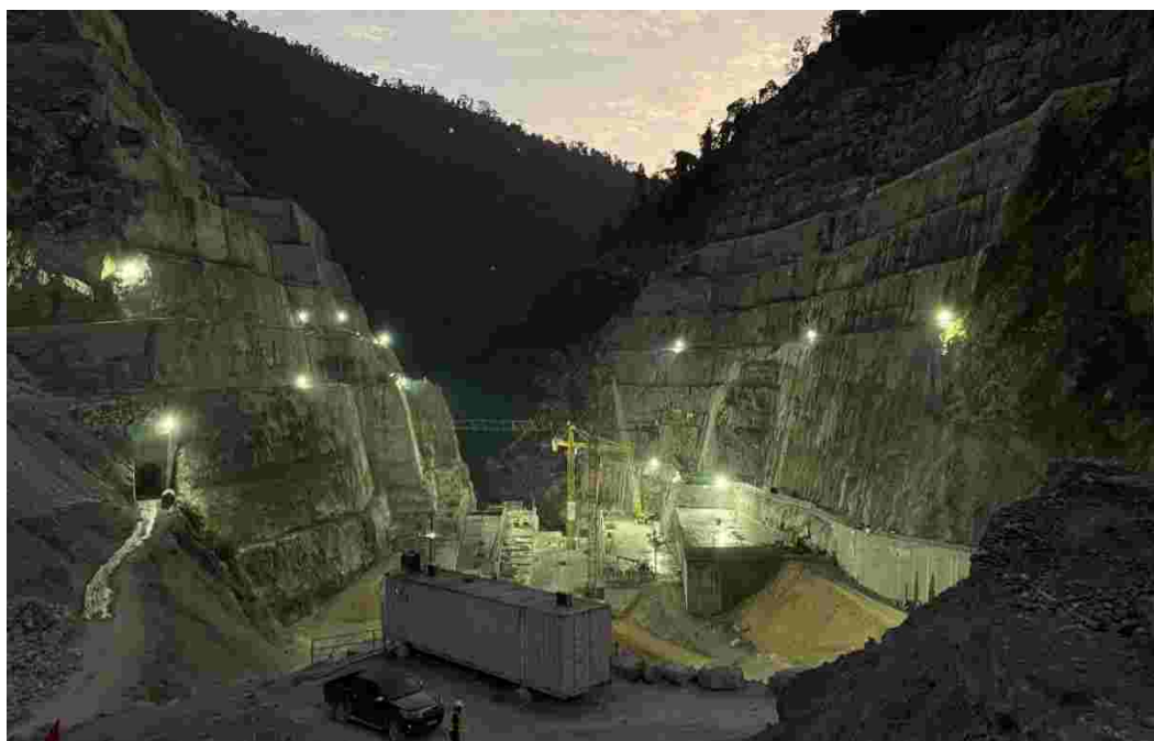
図 10-13 Tanafu Hidropower Dam Site の施工状況
