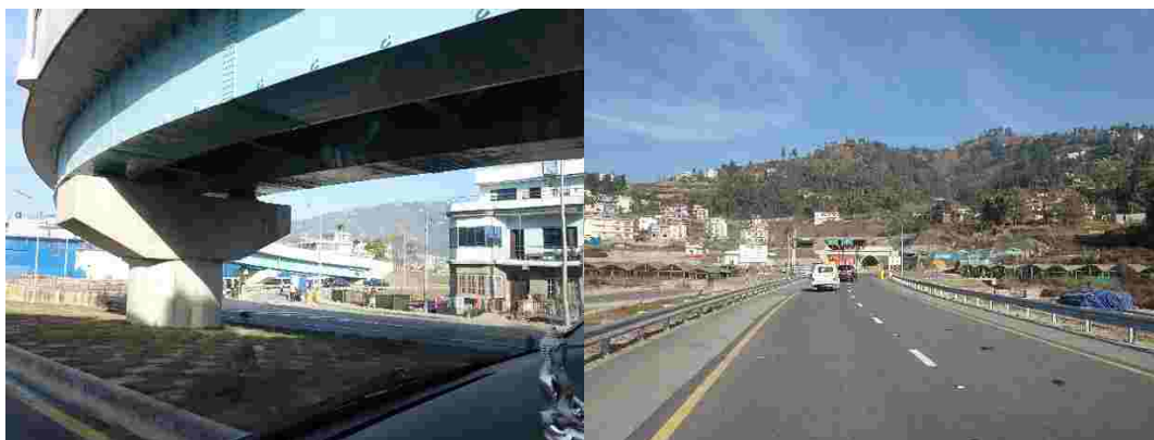
図 10-4 ナグドゥンガ・トンネルの東側の取り付け道路
