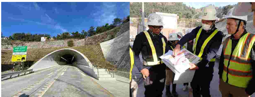
図 10-5 ナグドゥンガ・トンネルの東側坑口および工事の経緯を説明する中谷氏
