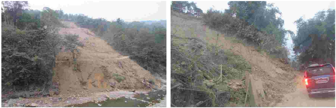
図 11-38 Spot12：メチ・ハイウェイの2025年10月の降雨による地すべり災害
