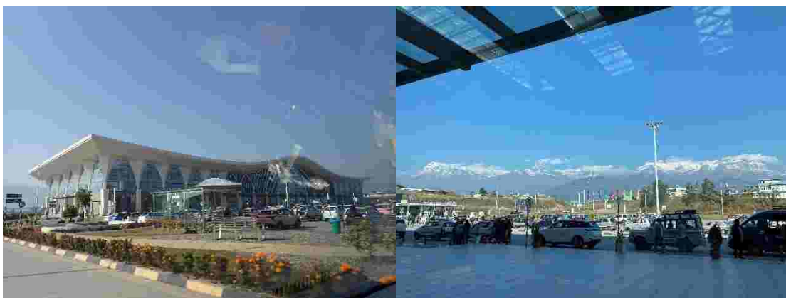
図 10-23 ポカラ国際空港と空港建物からの眺め
