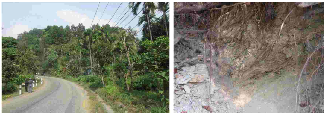
図 11-26 SPOT6 MBT 通過地点と弱変成砂岩・泥岩からなる地すべり移動体
