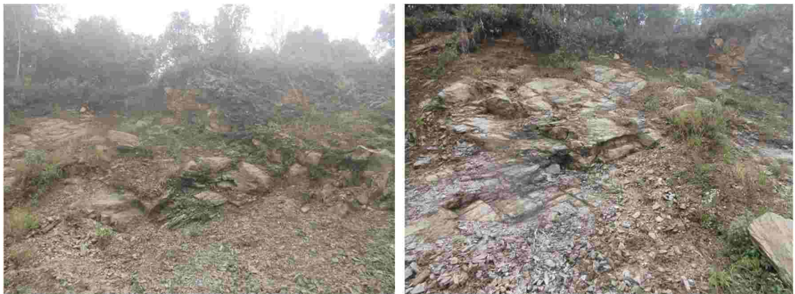
図 11-31 SPOT9：開口割れ目が発達した脆弱な片麻岩(古期地すべり移動体)
