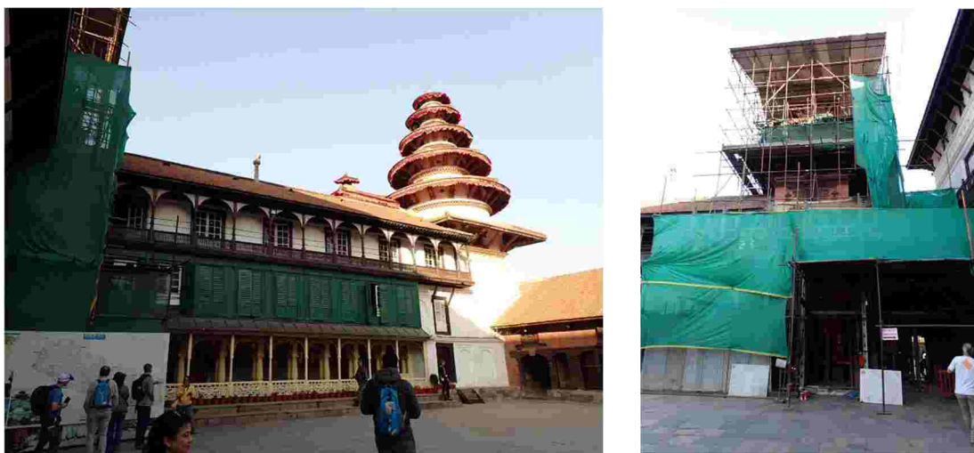
図 8-10 ハヌマン・ドカ内の建造物の復旧状況
