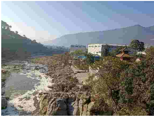
Chobhar 溪谷下流側
