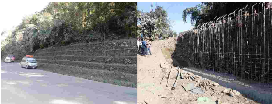
図 10-11 クリシナ・ヴィルの地すべり対策工
