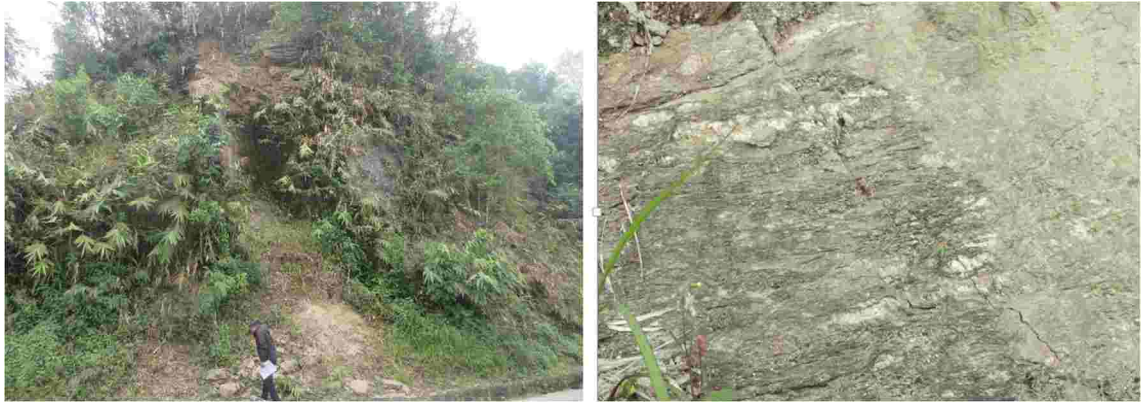
図 11-30 SPOT8：風化を受けて脆弱な大ヒマラヤ帯の片麻岩(古期地すべり移動体)
