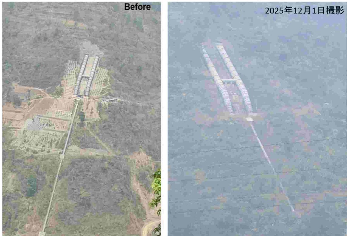
図 11-37 SPOT11：マイベニ水力発電水圧管路斜面の斜面安定工の成功事例
