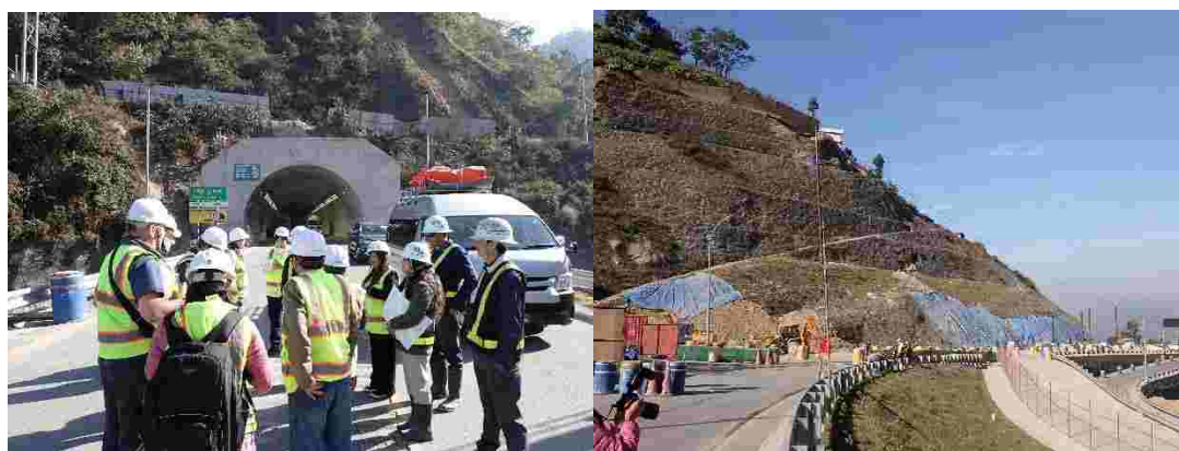
図 10-7 ナグドゥンガ・トンネルの西側坑口(左)と料金所わきの斜面(右)
