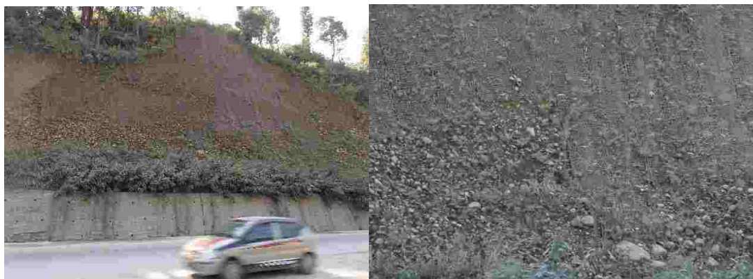
図 10-8 ガルチ付近のジュートネットを利用した在来のり面对策工
