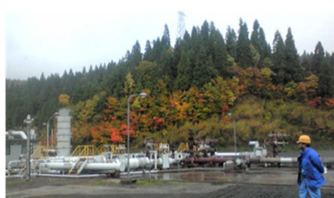
写真 景観に配慮した地熱発電設備（秋田県・上の岱地熱発電所）施設は、高さを抑えた配置、周辺と調和する色調などの配慮がみられる
