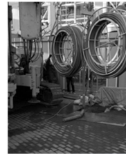
写真 日本大学文理学部に設置されている地中熱ヒートポンプの熱交換器（ダブルUチューブ）。
