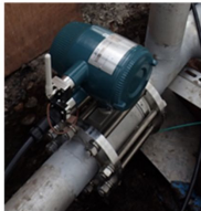
写真 温泉配管に設置した温泉モニタリング装置（温度、流量、電気伝導率：通信回路付）の例
