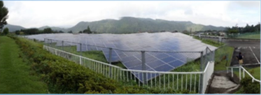
写真 愛川太陽光発電所。段丘の緩斜面を造成し太陽電池モジュール（上段1,574枚，下段6,328枚）を配置
