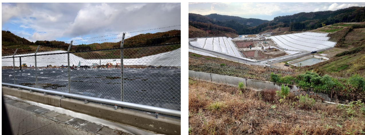
図8 埋立地の状況（令和6年11月21日撮影）
