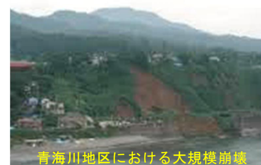
砂丘中腹斜面での崩壊・擁壁転倒
