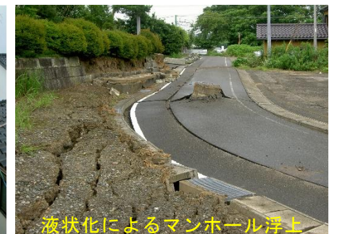
砂丘中腹斜面での崩壊・擁壁転倒
