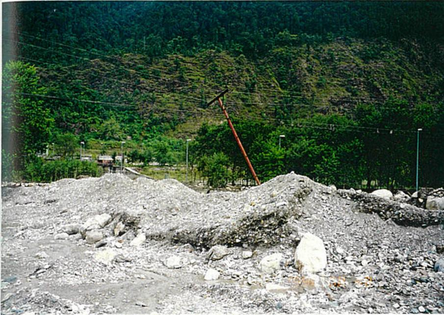
写真9 「マルシャンディ水力発電所ダム付近の土石流堆積物」
