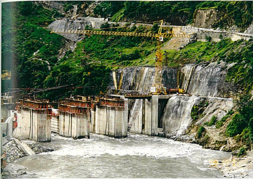
写真4 「建設中のコンクリート重力式ダム」
