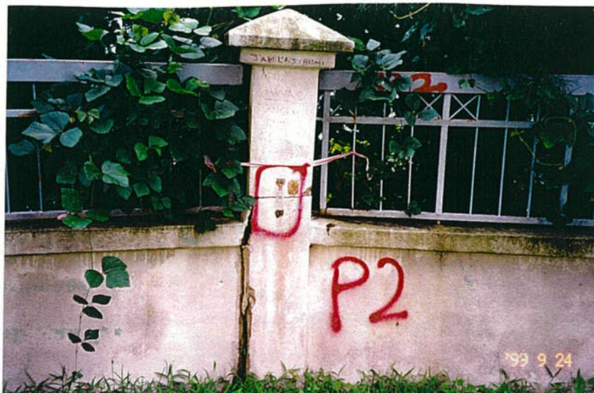
写真6「地滑り地点3 塀の亀裂と取り付けられた変位計」
