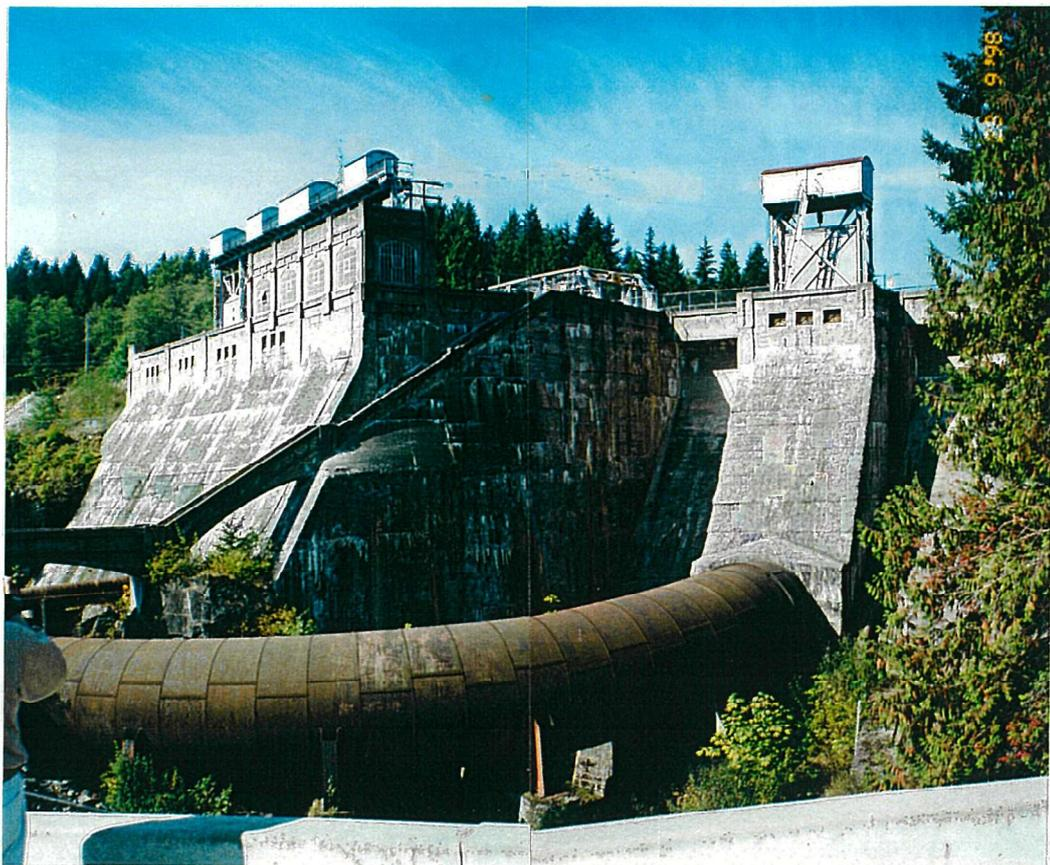
写真-8 既設ダムとダムから延びる水圧管路。構造的にかなり奇異な感じを受ける。
