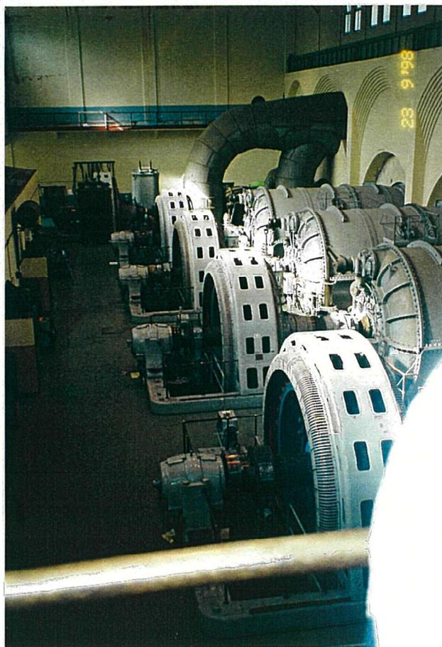
写真-9 既設発電所内部の状況。奥に見える二股のチューブは5基目の水車用の水圧管である。
