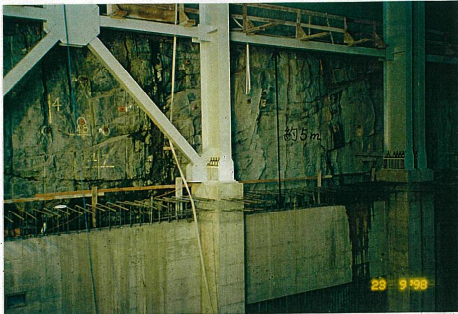
写真-3 新設発電所建屋内の施工状況。壁面は $90^\circ$ で掘削されているが、壁面保護はロックボルトおよび吹付コンクリート（写真上端）のみ。ロックボルト箇所矢印が付されているが、地質技術者が節理の組み合わせを考慮し、現場で指示しながら施工しているようである。
