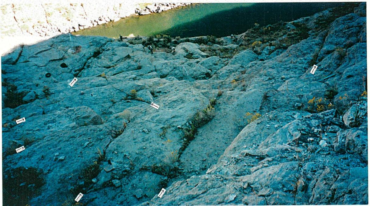
写真一 7 左岸アバット中～低標高部の高角度節理
