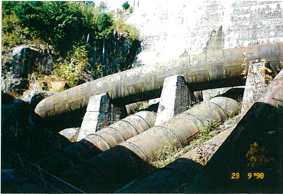
写真-10 既設ダムに全面に蛸足様に配置された水圧管路。
