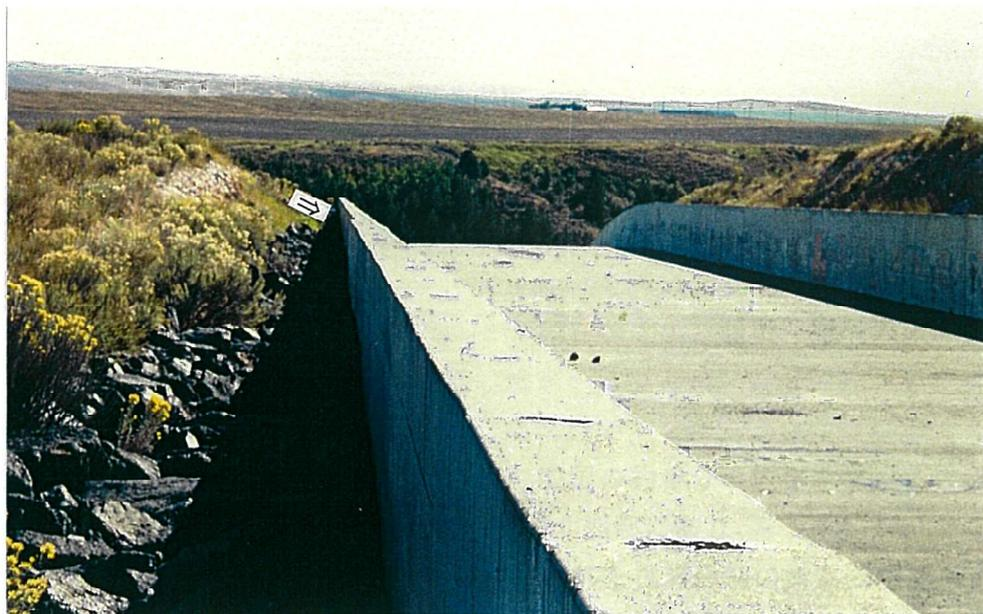
写真-10 洪水吐き側壁厚の不連続
