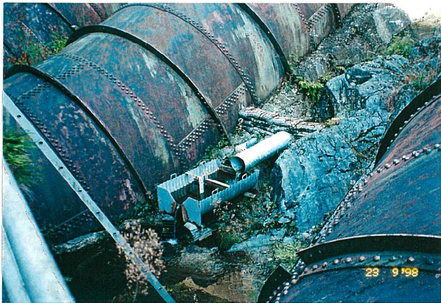
写真-11 ダムからの漏水量をドラム缶を利用したノッチ箱で観測している。
