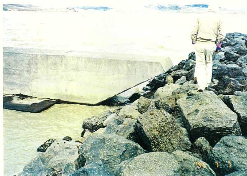
写真 5-4-3 コンクリート壁と 岩石消波堤防の 接合部
