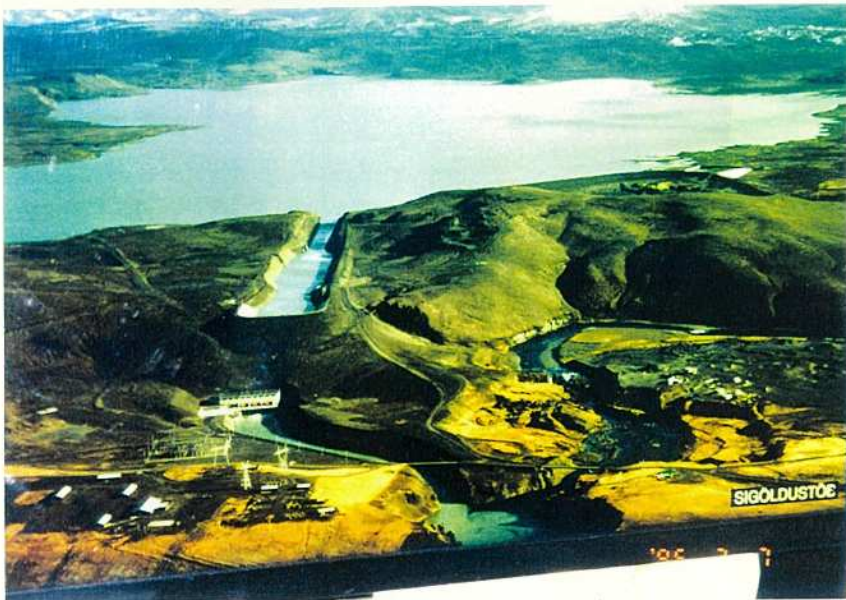
写真 5-4-1 シガルダダム全景
