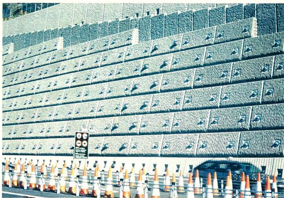
写真 4-5-6 Llanfairfechen 高速道路の法面保護工
