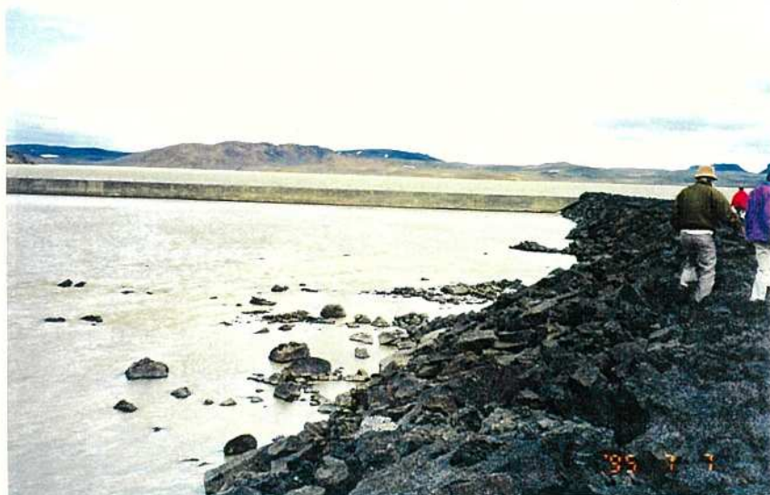
写真 5-4-2 洪水吐きの コンクリート壁と 岩石消波堤防
