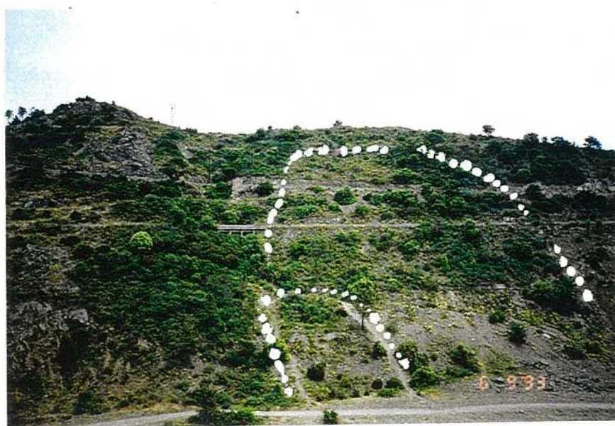
写真 2-2-35 ダム堤体下流 左岸に認められる地すべり地形
