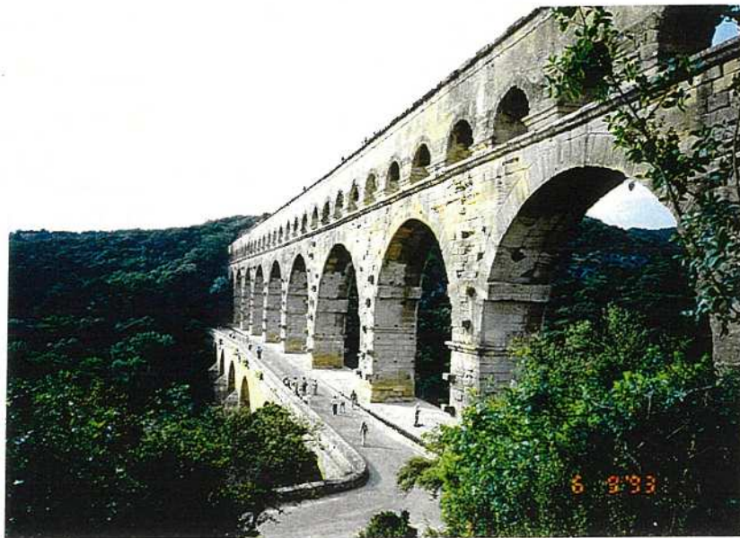
写真 2-2-33 ポン・デュ・ガール 左岸下流より
