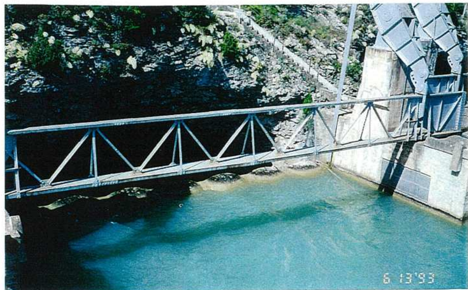
写真 2-2-18 同上。トンネルは素掘り。
