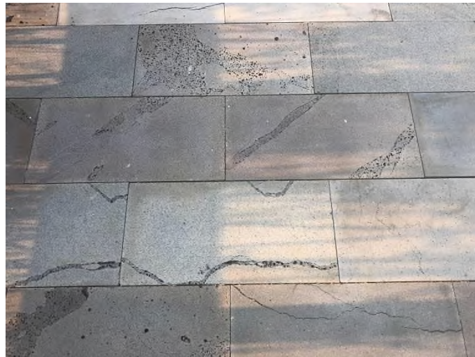
写真－6.1.2 歩道に使用されている玄武岩
