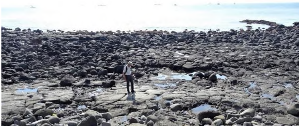
写真－5. 2. 10 海蝕台に露出する玄武岩は柱状節理が発達する
