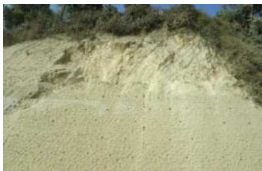
強風化した基盤岩とのり面保護工
