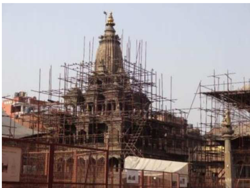
写真－4.4 修復中の寺院
