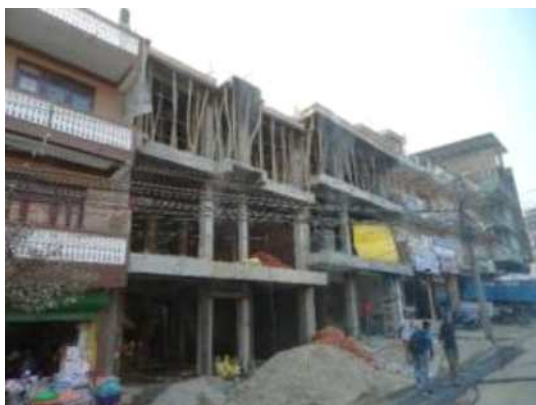
地震で被災したのか、建築中の建物。柱と床はコンクリートで、壁はレンガ積みか。型枠を竹のつかえ棒で支えている。
