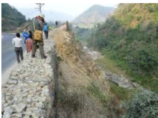
谷側斜面も急崖をなし、斜面に平行な高角度亀裂が発達して座屈変形や微小すべりが生じている。
