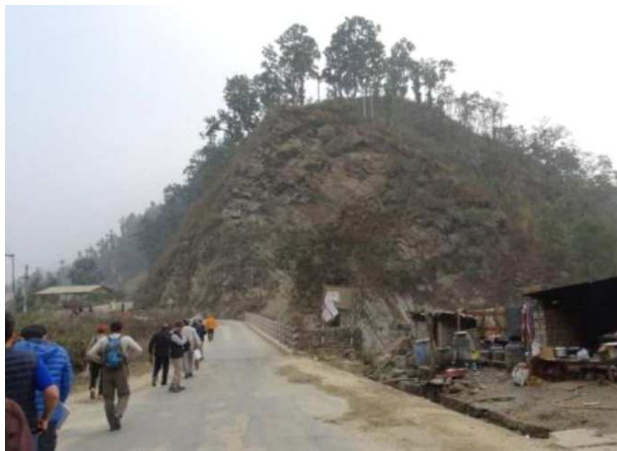
写真－6.2 トップリングによって変形したと考えられる片麻岩露頭
