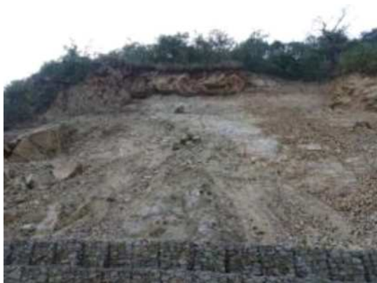
フトンカゴ工により対策されているが、崩壊面には不安定な岩塊が点在して落石の危険。真下で観察するのは非常に危険であるため、急いで移動。
