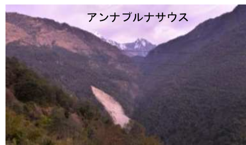
写真－9.24 バンタンティ直下の深層崩壊
