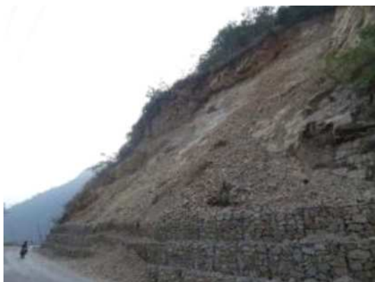
道路斜面崩壊箇所。崩壊面に節理面が露出し、頭部や側方に不安定岩盤が残る。
