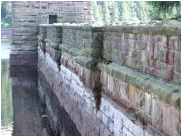
写真－7 Howden Dam 上流面 壁面に凹凸を持たせている
