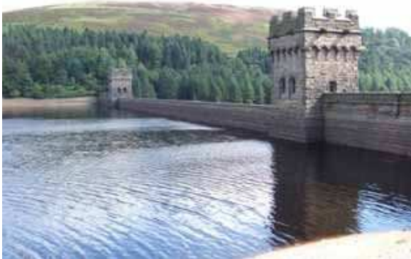
写真－5 Derwent Dam 堤体も左右対称に配置されている 中央部が洪水吐
