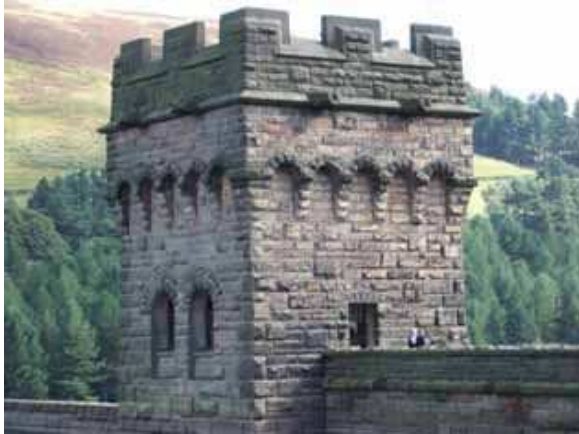
写真－6 堤体上の古風な管理塔 博物館としても使用
