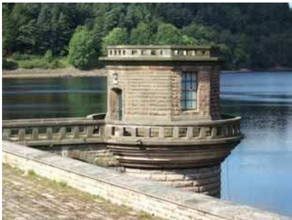
写真－8 Ladybower Dam 取水塔 両岸に1つずつあり、周囲にマッチし ている
