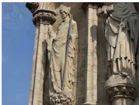
写真-6.3.9 酸性雨の影響で表層がやや溶解した彫像
