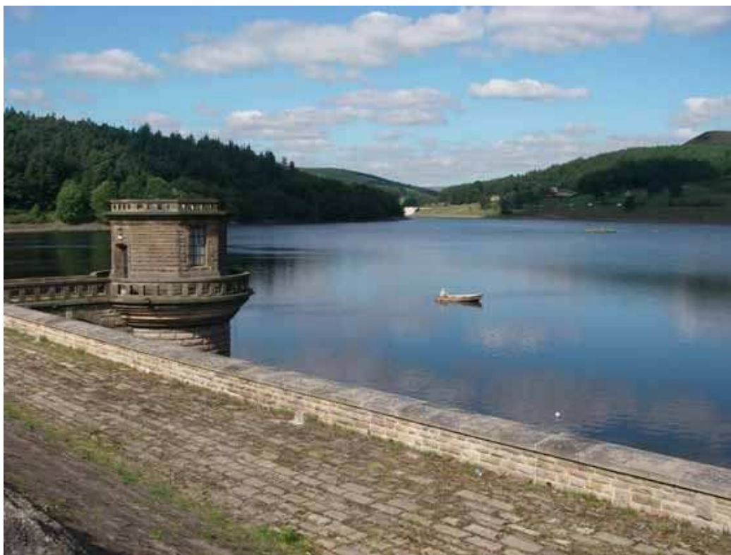
P-8：Ladybower ダム 貯水池。見えているのは取水塔？。湛水面より上部は石張。
