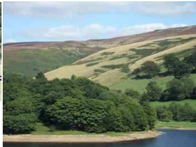
写真－6 最上流の Howden Dam の上流域 樹木は伐採されて荒地となっている
