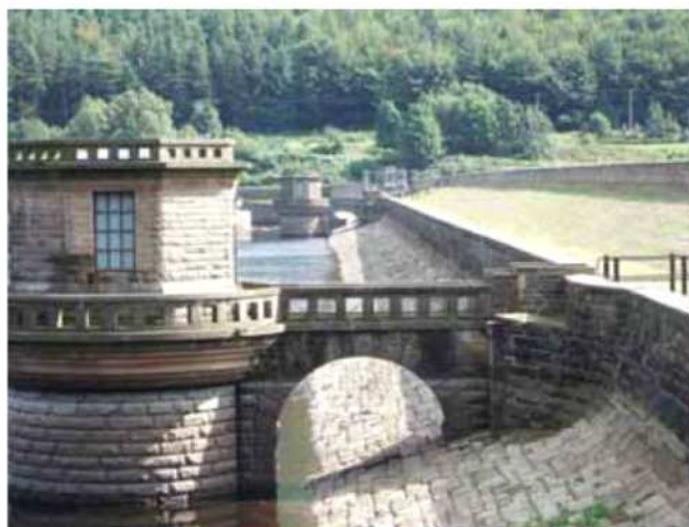
写真-7 Ladybower Dam 上流面と取水塔 デザインと入念な石工、管理が偲ばれる
