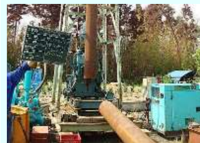
代替水源井戸の設置(亘理町)
