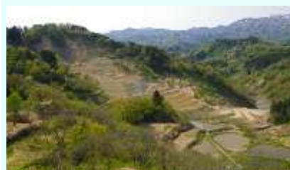
復旧した清水の棚田(十日町市)
