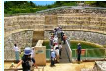
福里地下ダム水位水質観測施設(宮古島市)
