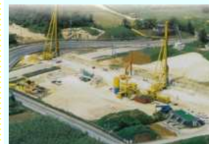
地下ダム建設工事現場(宮古島市)
