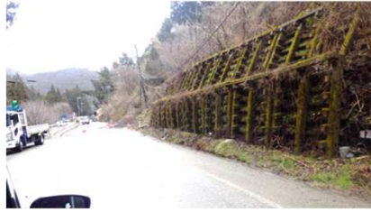
左：地震後3月のC変形した枠組み擁壁（斜面の押し出しにより変形、上部斜面は緩みあり）
