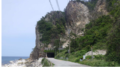
八世乃洞門の1月地震後の 斜面の緩み状況（2024年5 月26日撮影）
