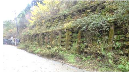
左：地震後3月のC変形した枠組み擁壁（斜面の押し出しにより変形、上部斜面は緩みあり）
