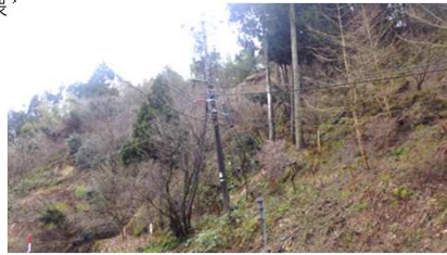
左：地震後3月のD変形した地すべり対策工斜面（植生は残っている）
