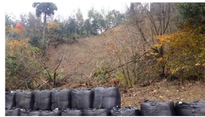
左：地震後3月のD変形した地すべり対策工斜面（植生は残っている）
