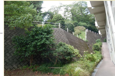
ブロック積擁壁工
