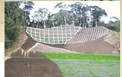
切土工及び法枠工
