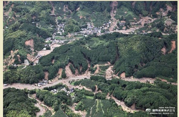
2017年九州北部豪雨杷木地区 斜面崩壊と土砂洪水氾濫
