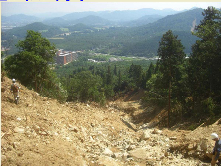
写真1(C6) 平成30年西日本豪雨災害 東広島市で発生した土石流
