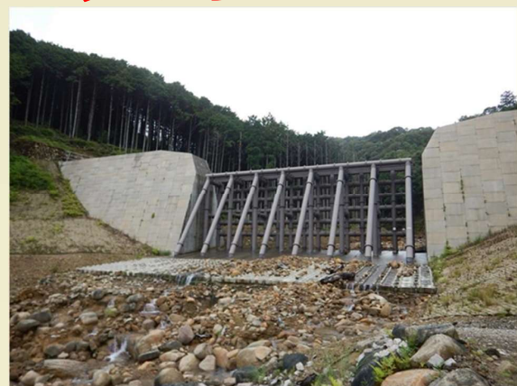
透過型砂防堰堤の例
