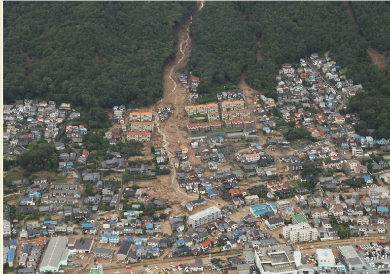
2014年広島豪雨災害で発生した土石流 安佐地区(国際航業・パスコ)
