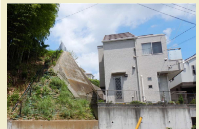
もたれ擁壁工
