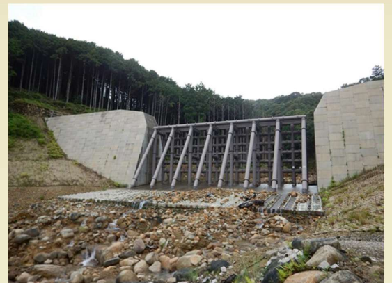
図21-3 透過型砂防堰堤の例
