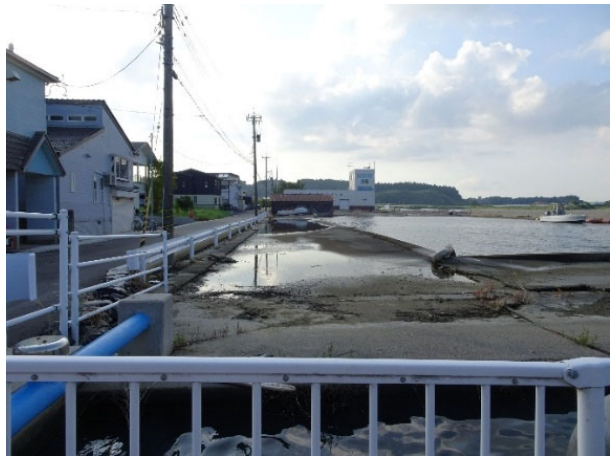
なぎの浦港湾施設の浸水
