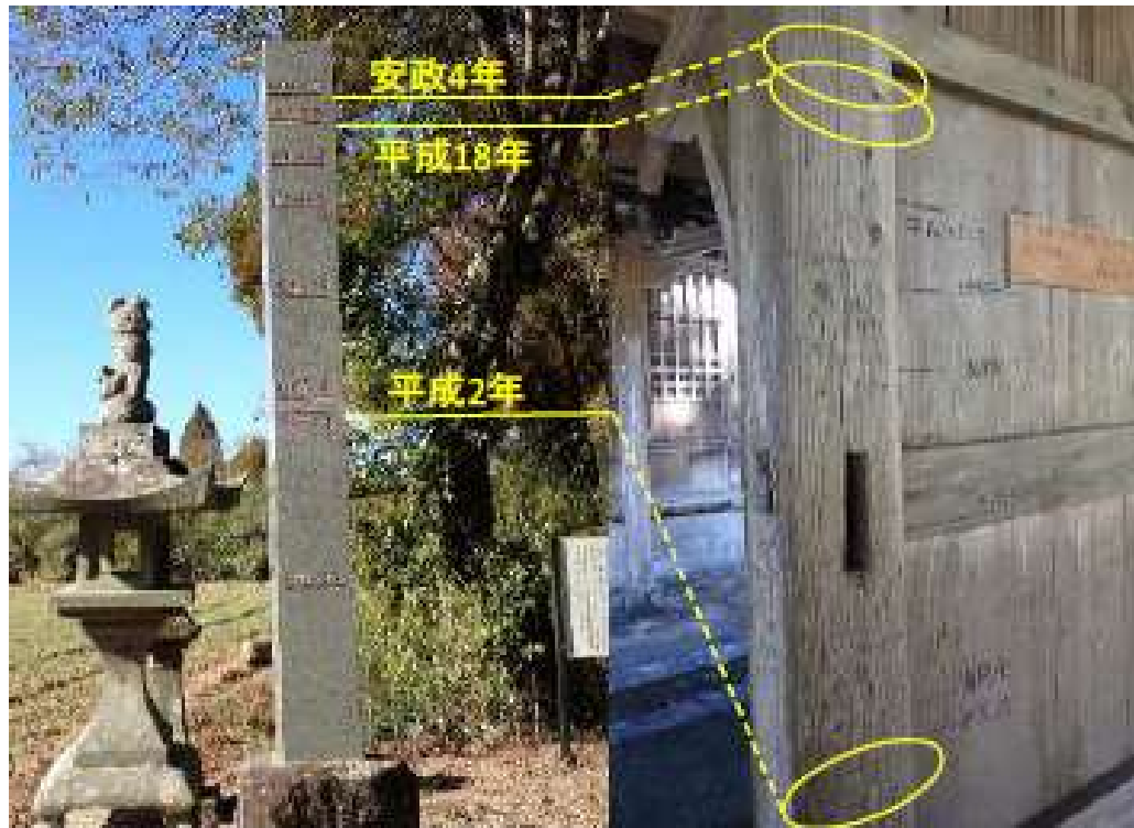
(上)大川野宿の輪中堤 (左)洪水記録碑の水位線と拝殿奥柱 に刻まれた浸水深記録の対比 (藤永地建・山田氏作成)
