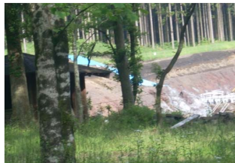
f) 西側 300m 離れた地点の法面崩壊
