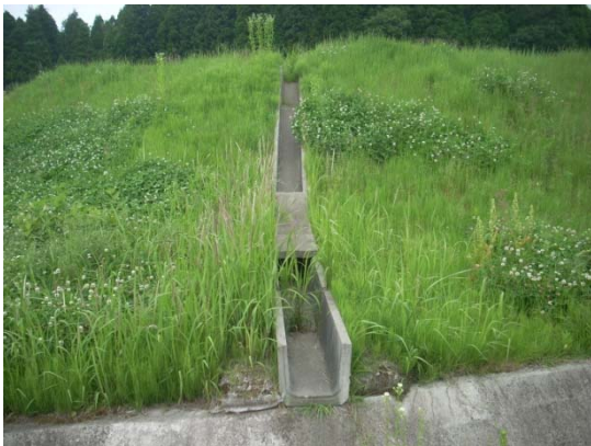
c)法面流下側溝に変状なし
