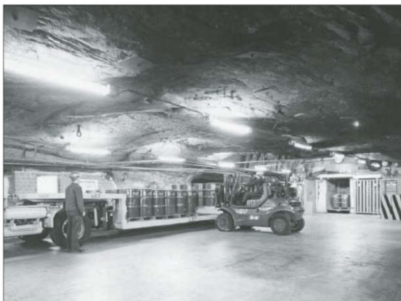
図 5-4-1-2 地下への廃棄物の輸送状況 3)
