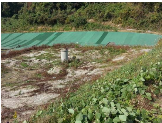
(b) 豎形集排水管の設置例（左）と設置されていない例(右)
