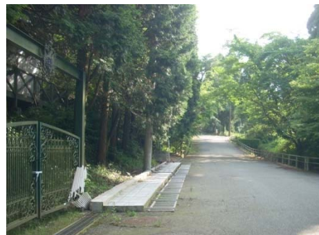
g) 西側 550m 離れた地点の塀の倒壊
