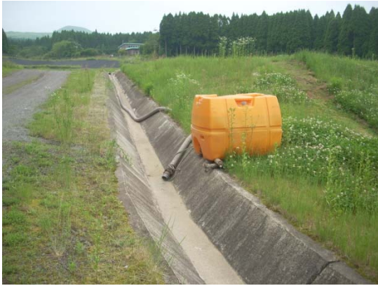
a)側溝の変状なし
