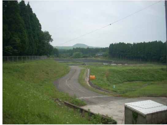
d)道路法面（写真左）に変状なし
