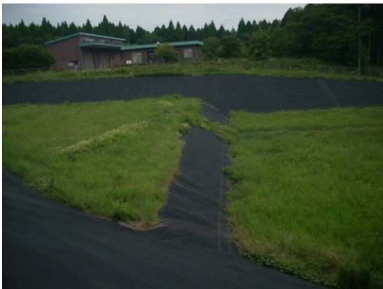
浸出水集排水施設：やや白色の植生部
