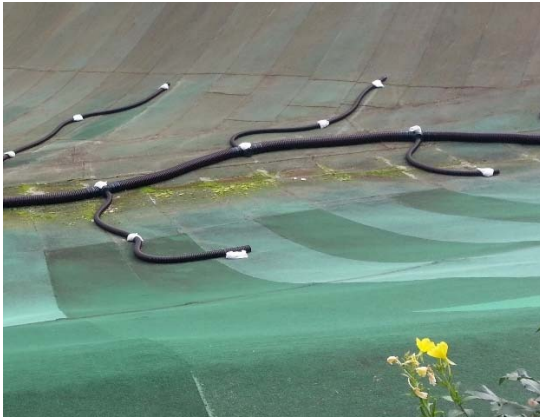
(a) 底部集排水管の設置例（埋立前（左）と埋立中（右））
