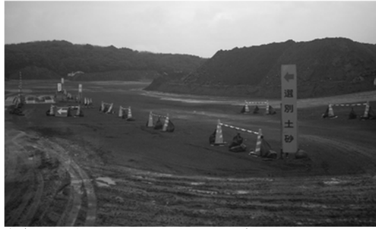
(b) 二次仮置場の例（分別ヤードが設置されている。2014年11月1日撮影）
