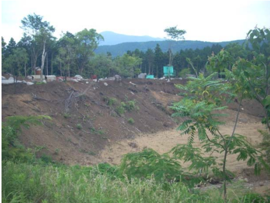
a) 処分場内の造成部
