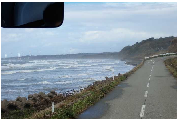
P6 安田海岸の様子。波が海食崖直下まで迫っている。海岸線を歩いて観察する予定でした。
