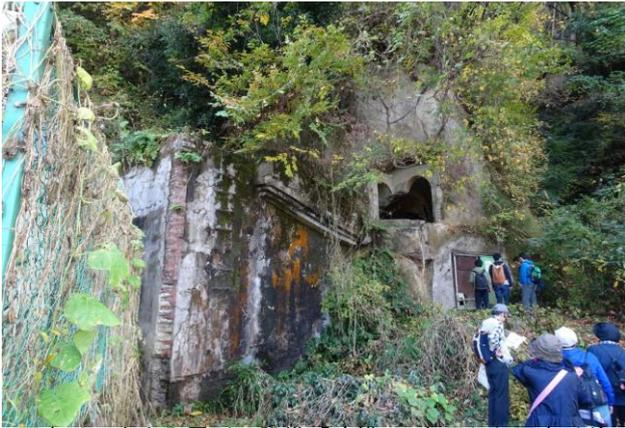
写真-9 水力発電所の設備「遺構」。空洞から写真手前下方に管路で水を落とし、発電していたと思われる。
