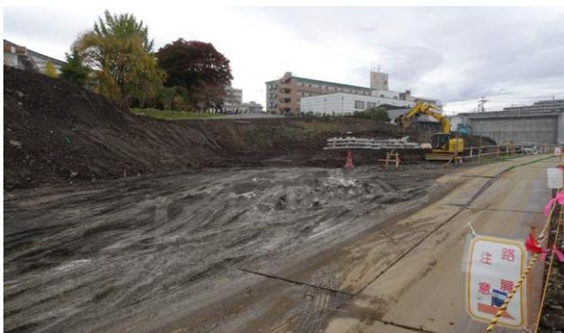
写真-3 長町 - 利府線の撓曲崖 道路工事の切土で強調
