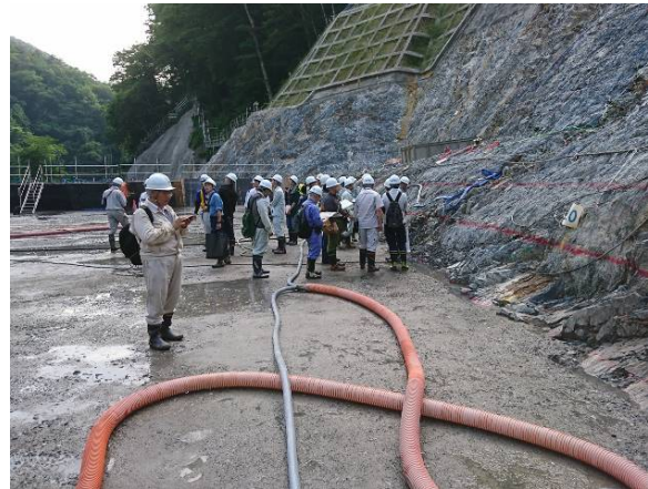
堤体右岸斜面
