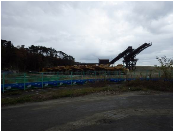
写真3：土砂運搬用ベルトコンベアー
