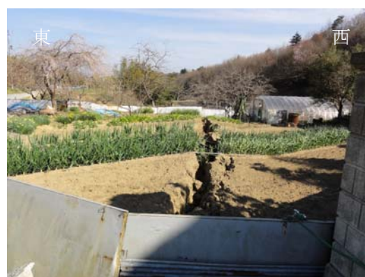
写真-4 開口した断層面 (2011.4.17 撮影)
