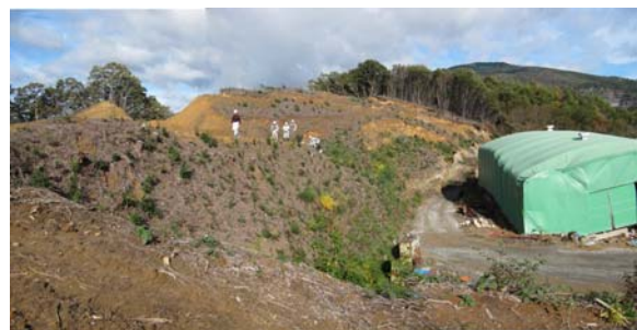
写真-8 上釜戸地すべり側方から頭部を臨む。地山はブロック化。
