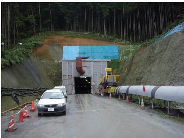
トンネル坑口とズリ運搬用のベルトコンベアー
