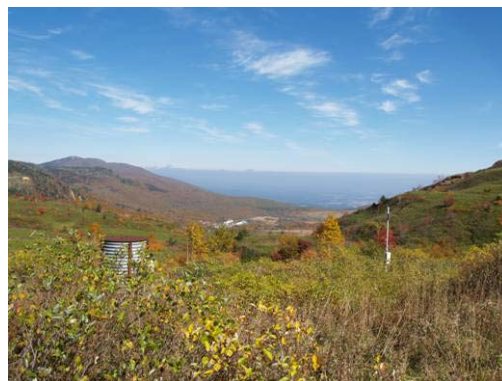
八幡平の地すべり対策工
