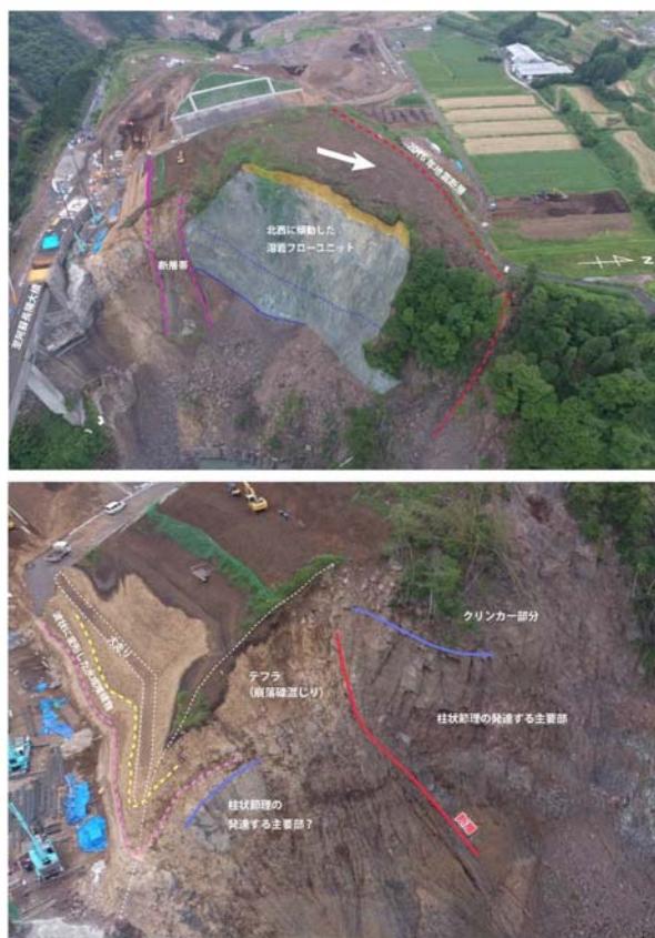
図4. 立野地区のテクトニックバルジ.
