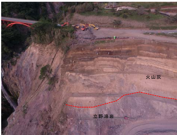
写真-2 左岸切土法面のフラワー構造
