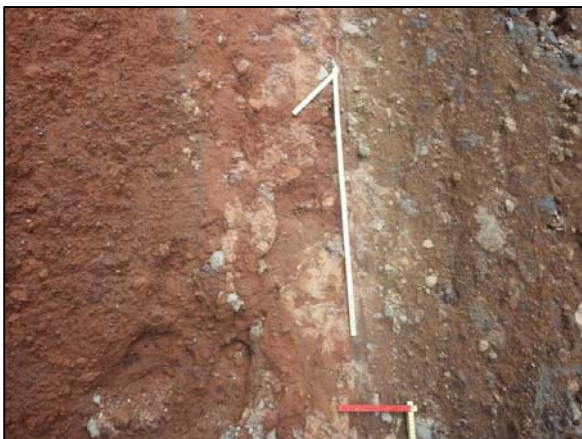
写真-3 桑鶴大橋工事現場切土の断層
