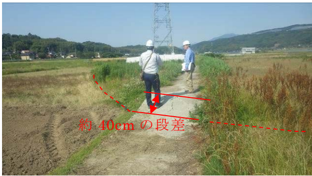
写真-2 益城町寺迫地区の地表地震断層
