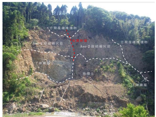
写真-6 木山川左岸崩壊地で確認される地表地震断層(背後の斜面に地震断層が連続する)
