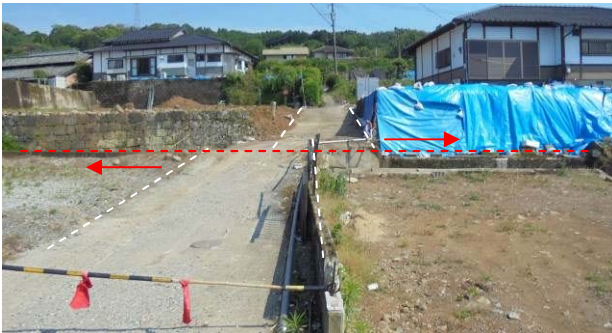
写真-3 益城町下陳地区宅地周辺の地震断層 (約1mの右横ずれ変位)
