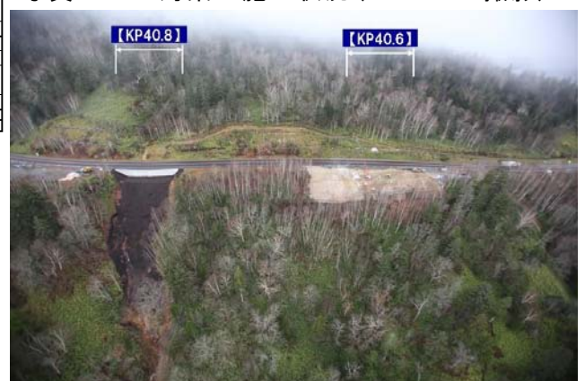
写真－3 対策完了後の状況 (H24.11.9 撮影) 謝辞
