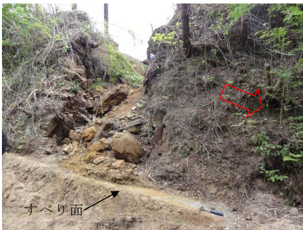
図 1 上釜戸地区岩盤地すべり頭部のすべり面と分離ブロック
