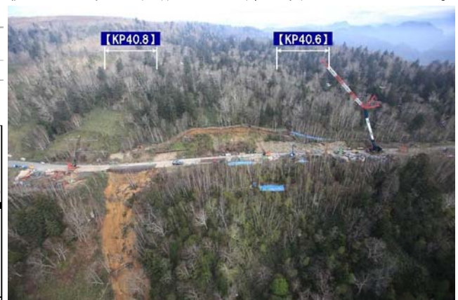
写真－2 対策工施工状況 (H24.5.14 撮影)
