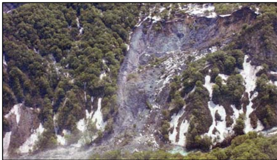
写真-1 崩壊地全景
