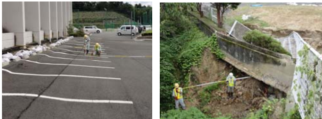
写真-1 路面沈下状況 写真-2 表層崩壊
