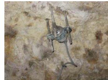
図2 海蝕空洞天端に設置した密閉型 AE 装置
