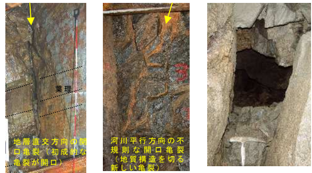
写真 3 開口亀裂(左・中)・空洞(右)
