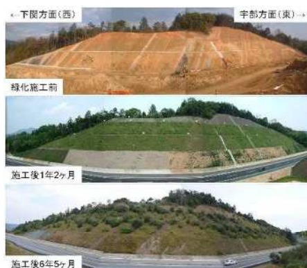
写真1 緑化試験現場の経年変化 (終点側南向き法面)
