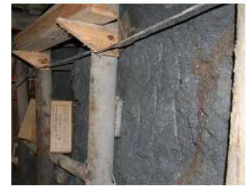
写真 4 ゆるみ岩盤中の塊状岩盤
