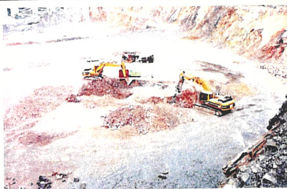
写真.2 供試体整形・作業ヤード掘削
