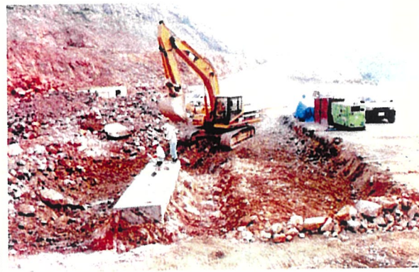
写真.4 垂直カット後、周囲の掘削
