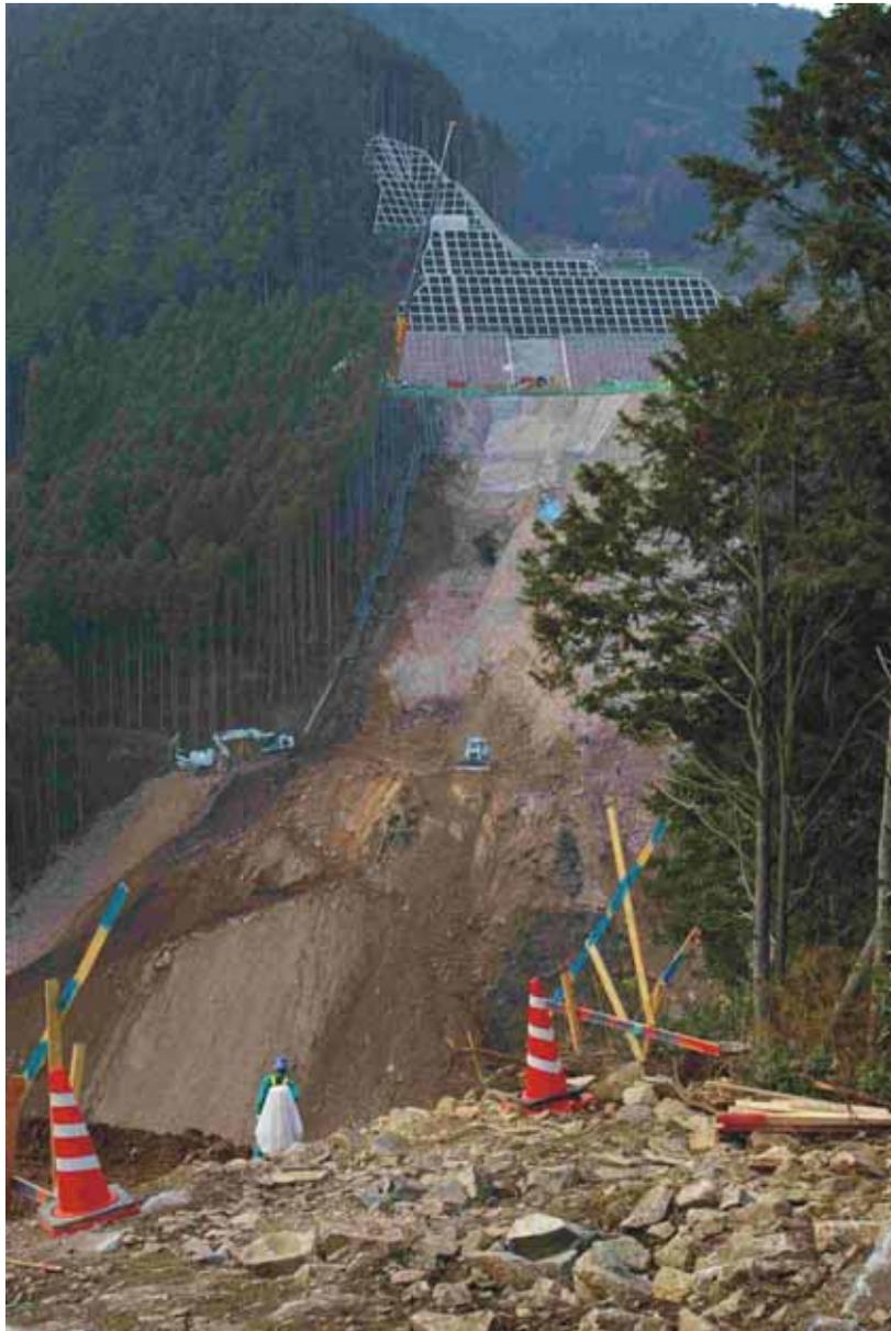
写真2 ダム基礎の掘削状況（左岸）
