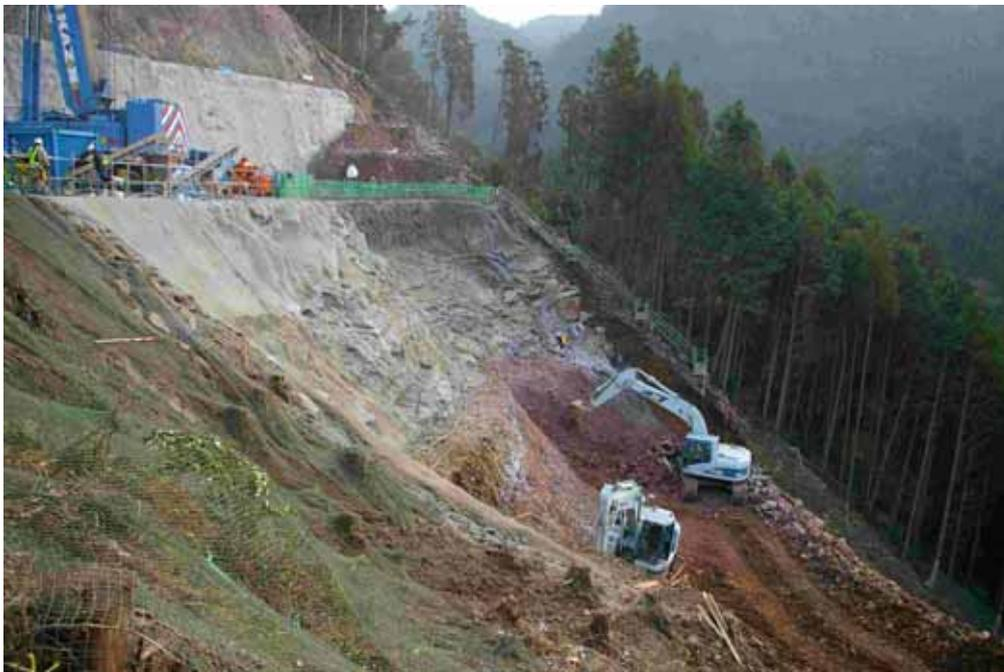
写真3 ダム基礎の掘削状況（右岸） 安山岩と自破砕安山岩が成層して分布
