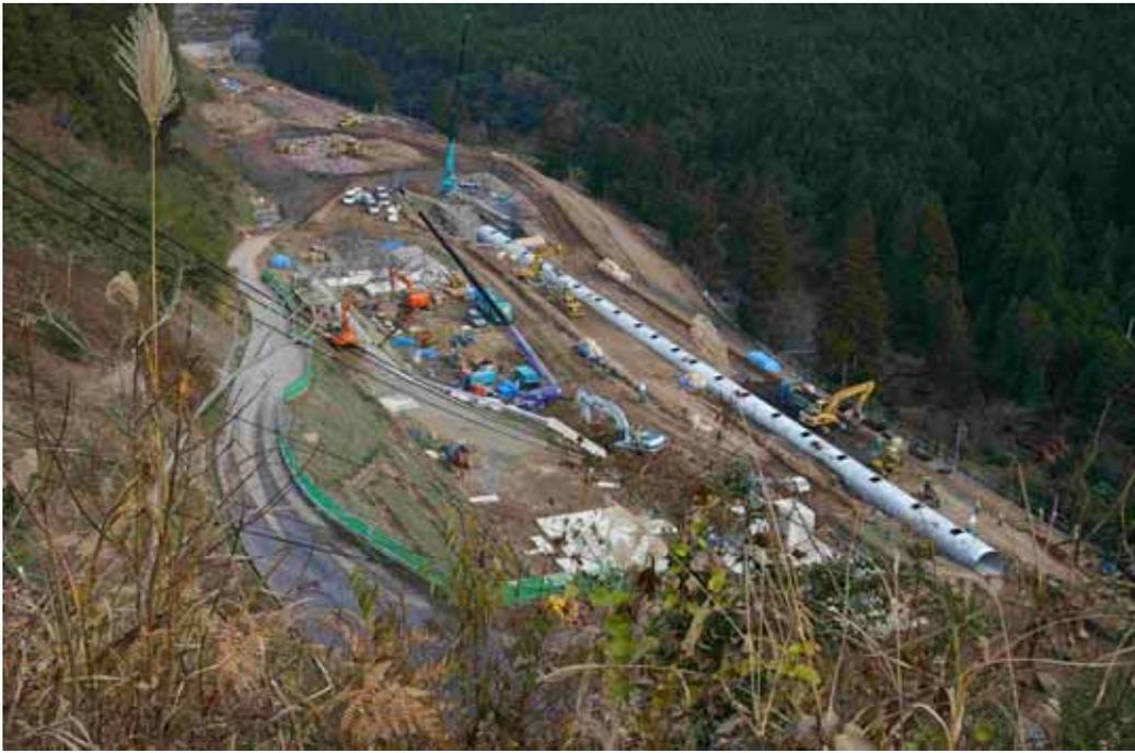
写真1 骨材プラント設置箇所の造成
