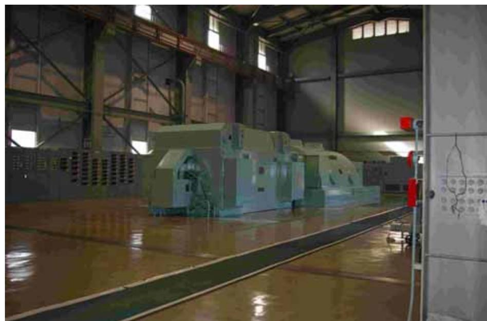
写真8 八丁原地熱発電所 発電機
