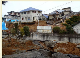
東日本大震災による盛土地すべり
