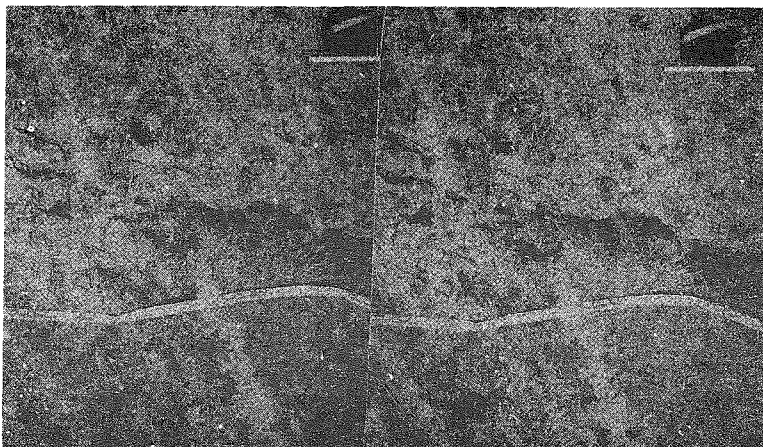
写真3 Photo 4 地点の立体写真
