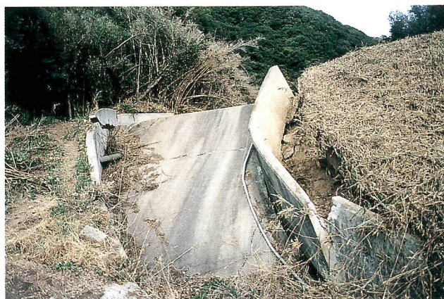
⑤ 断層横断によるため池余水吐の破壊〈北淡町大石〉
