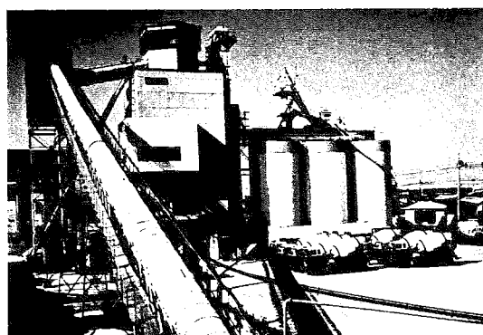
▲生コンプラント：製造能力 270m 3 /時
