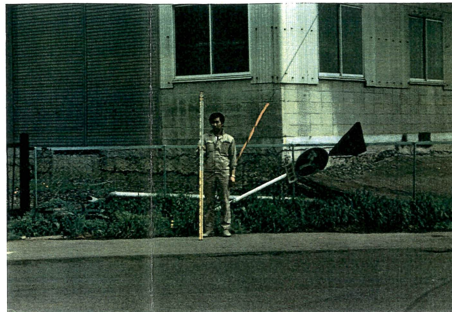
昭和47年頃の建物と考えられるが、支持杭で支持されており、建物自体の変状はみられない（建物は現在使用されていない）。
