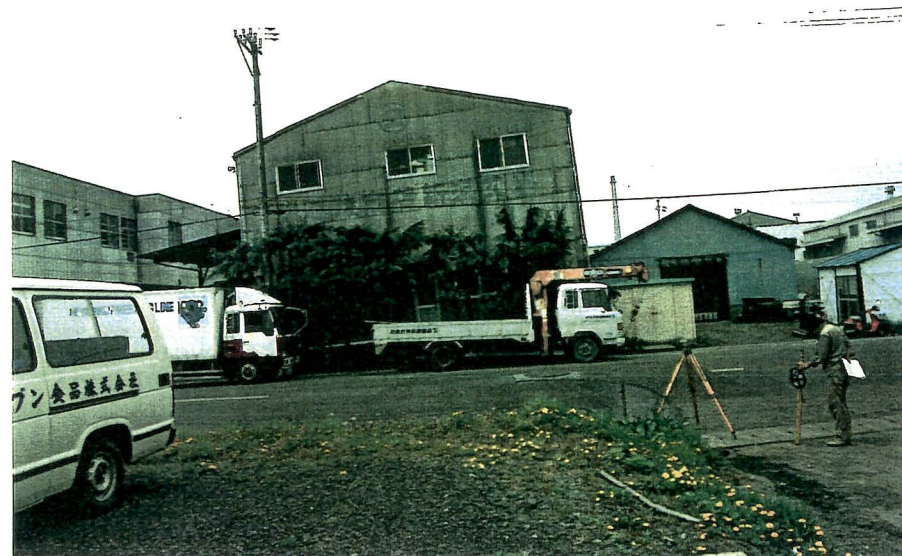
基礎形式は杭基礎（支持杭）を採用したが、写真左側の杭が地盤沈下により座屈し、建物が傾いている。
