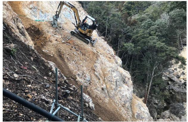
写真一2 高所無人掘削機の掘削状況
