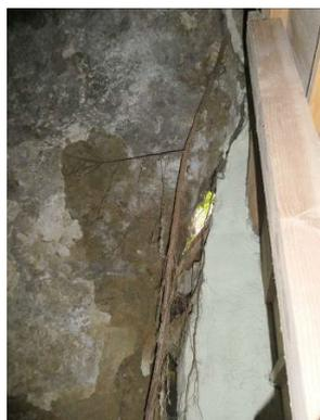
図-4 1号像付近の取り合い部の隙間(木の根が入り込む)
