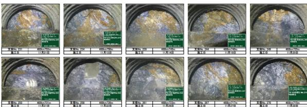
図-2 トンネル切羽の岩相が複雑に変化する様子
