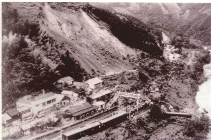
崩壊地全景（昭和47年7月5日午後）
