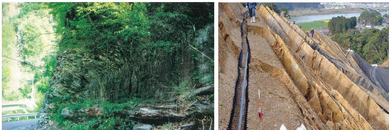
写真-1 斜面のトップリング（左：粘板岩<sup>2)</sup>：鉛直に近い地層の下方への折れ曲がり
