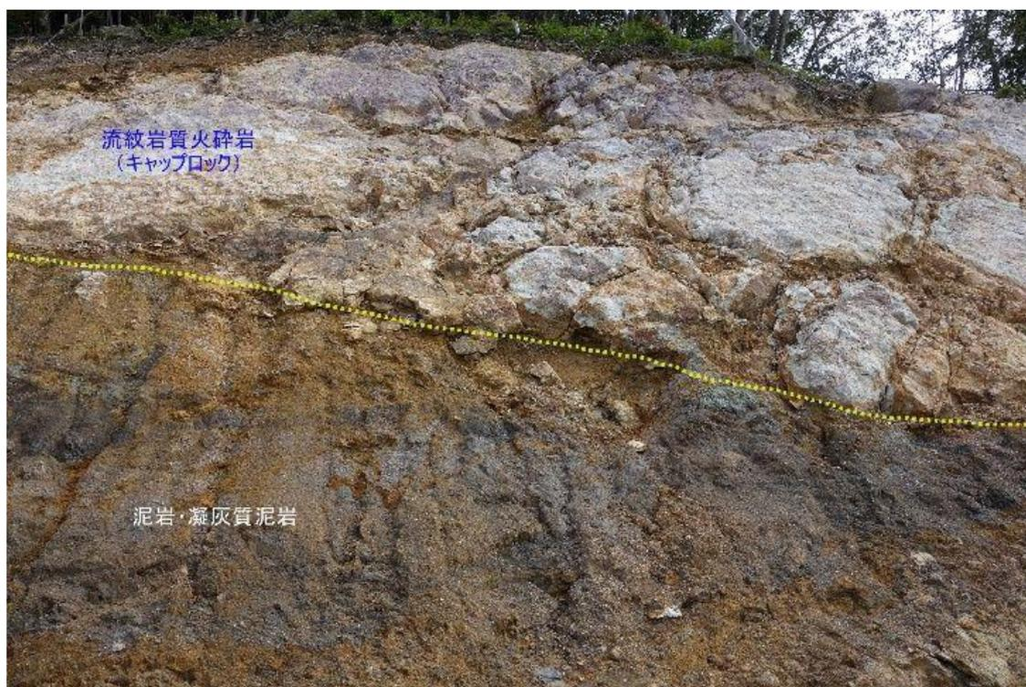
写真-1 切土法面に出現したキャップロック構造
