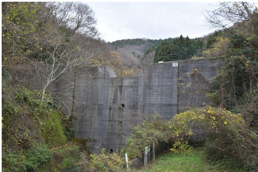
図-4 砂防堰堤（不透過型）
