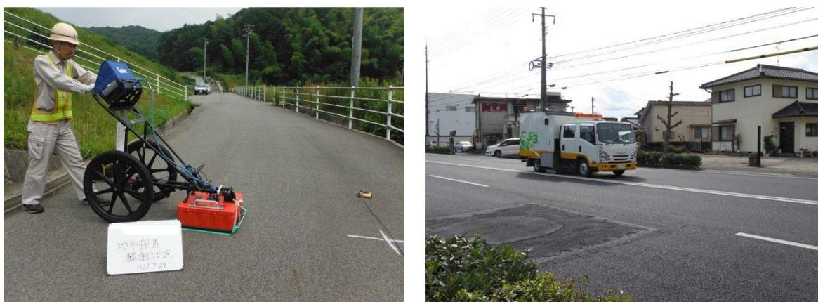
写真-1 探査状況 (左：手押し型、右：車載型)
