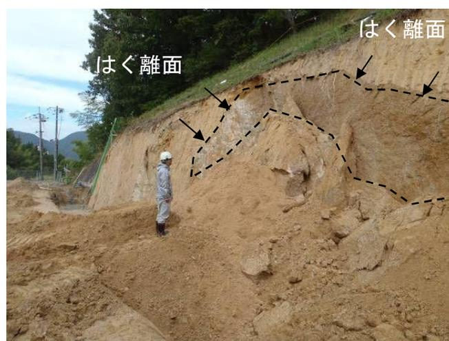
写真-3 粘土細脈をはく離面として崩壊が発生した事例
