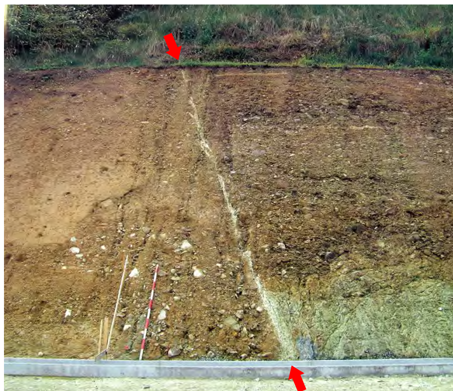
写真-1 断層写真 2)
