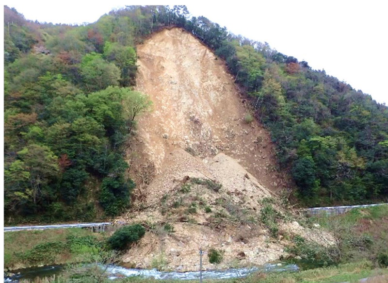
写真-1 斜面崩壊の一例
