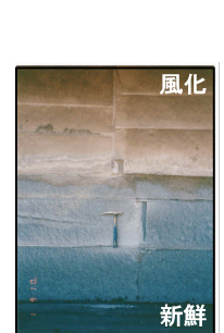
【急激な風化による褐色化】
