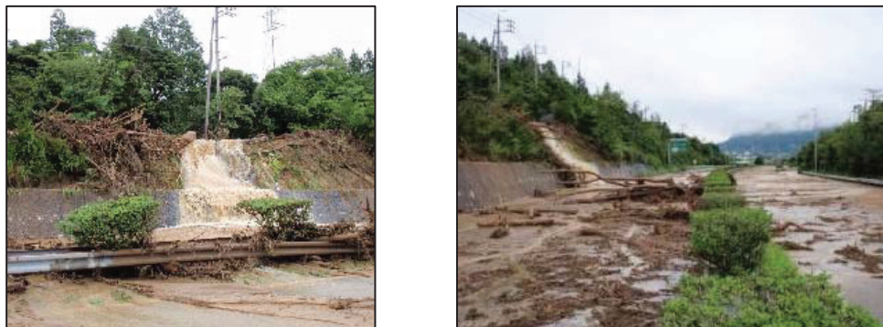
図-7 2009年7月中国自動車道山口インターチェンジにおける土石流発生状況
