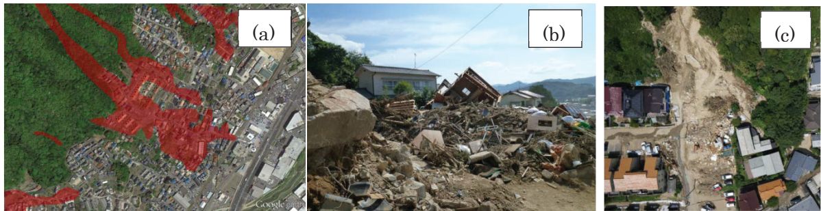
図-1 被害調査結果 a) 空中写真判読による土石流被害 2) (b) UAV から撮影された空中写真提供：荒谷建設コンサルタント) (c) 家屋被害の様子。奥側の家屋は被害を受けていない。
