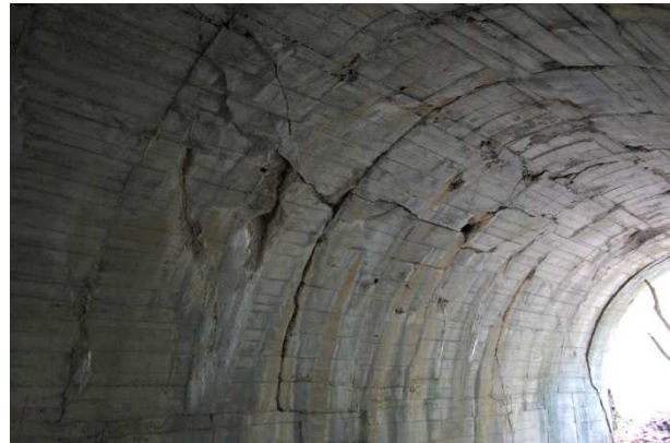
写真-1 A トンネルの変状（変形）
