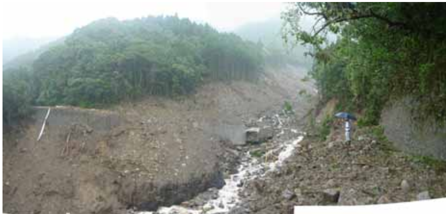
写真-3 国道493号の被災状況 人物の位置は元の路面。
