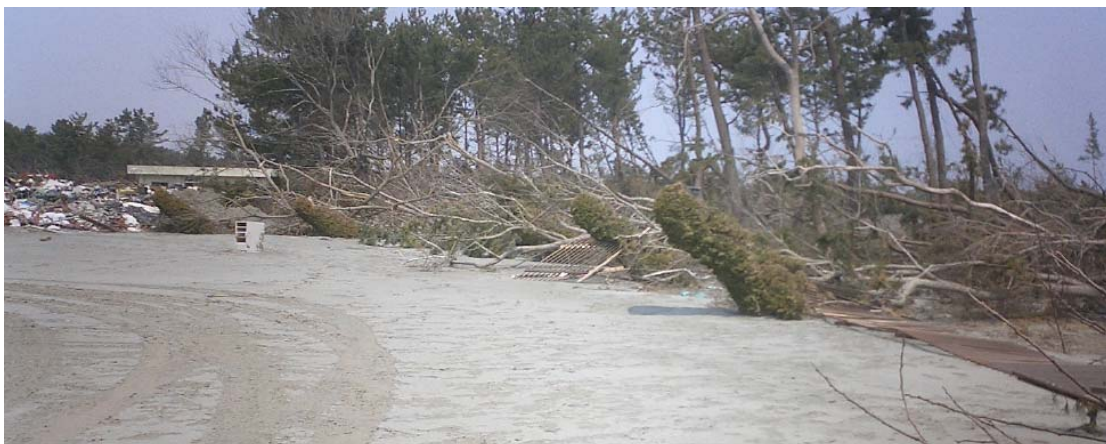
写真-3 浄化センター北の地点 A, 砂の上に泥の被膜が覆う
