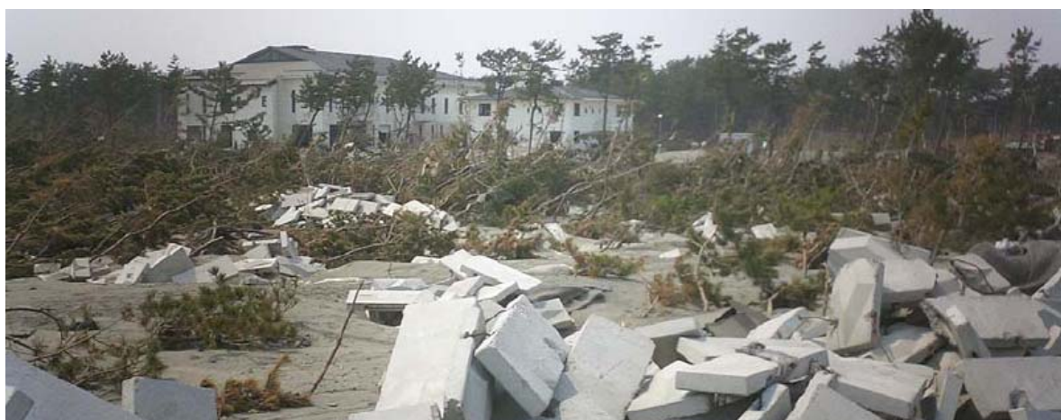
写真-5 海岸から見た浄化センター 散乱する護岸
