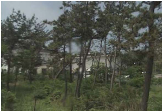
写真-1 被災前の浄化センター
