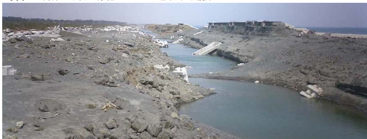
写真-6 海岸部 堤防の背後が波のローリングで抉れて、地平線まで続く溝が形成
