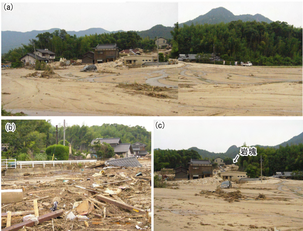
写真-2 石原地区の被災状況(2009年7月23日)
