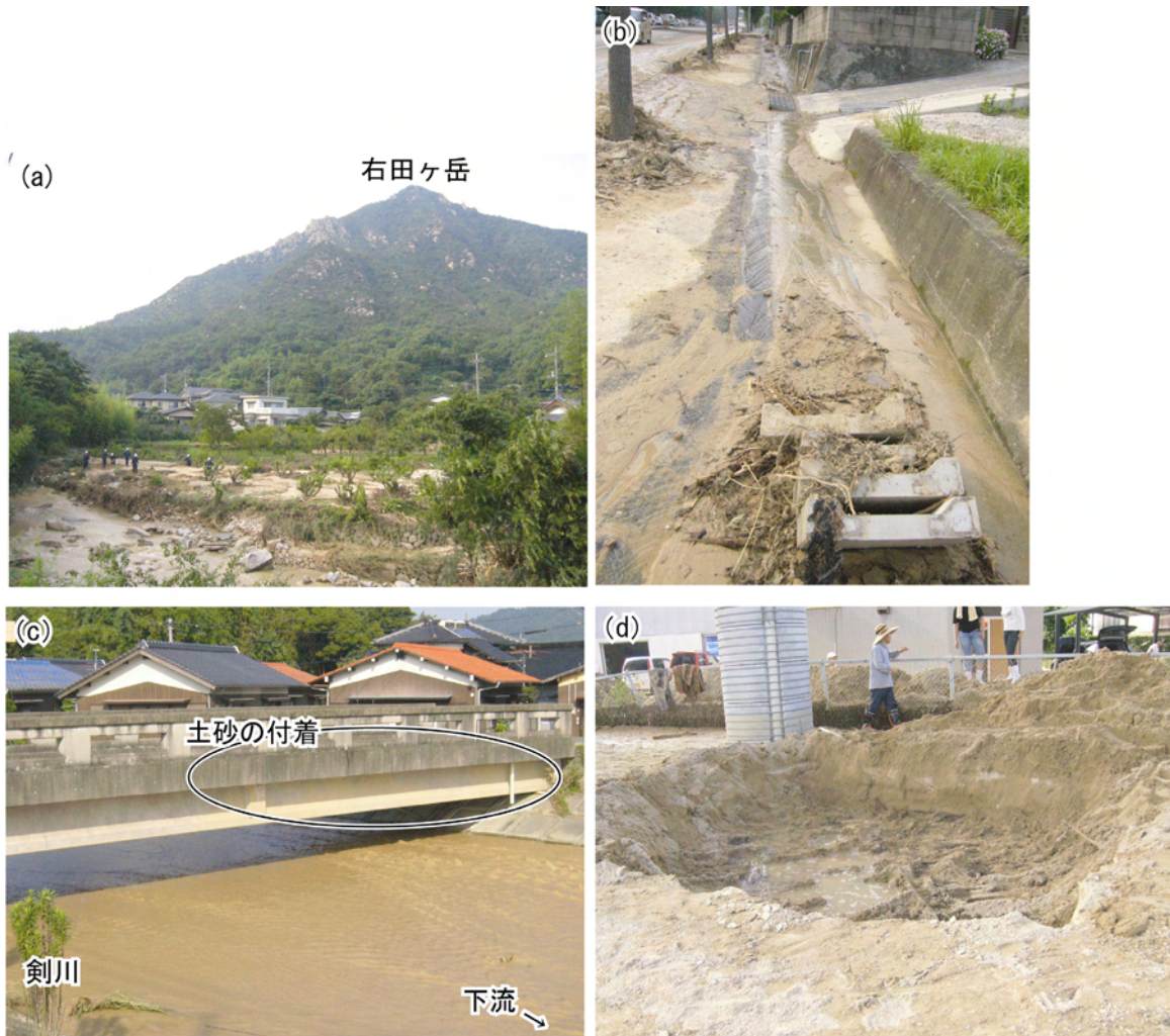
写真-1 神里地区の被災状況(2009年7月23日)
