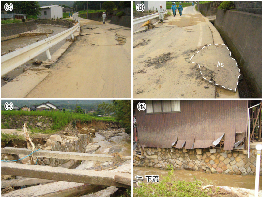
写真-3 真尾地区の被災状況(2009年7月23日)
