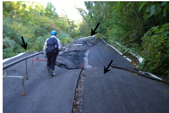
写真-5 アスファルトの沈降
