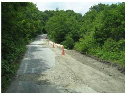
大型土嚢等による応急対策状況
