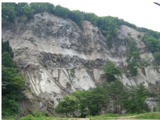
山腹崩壊（表層滑落と岩盤崩落）状況
