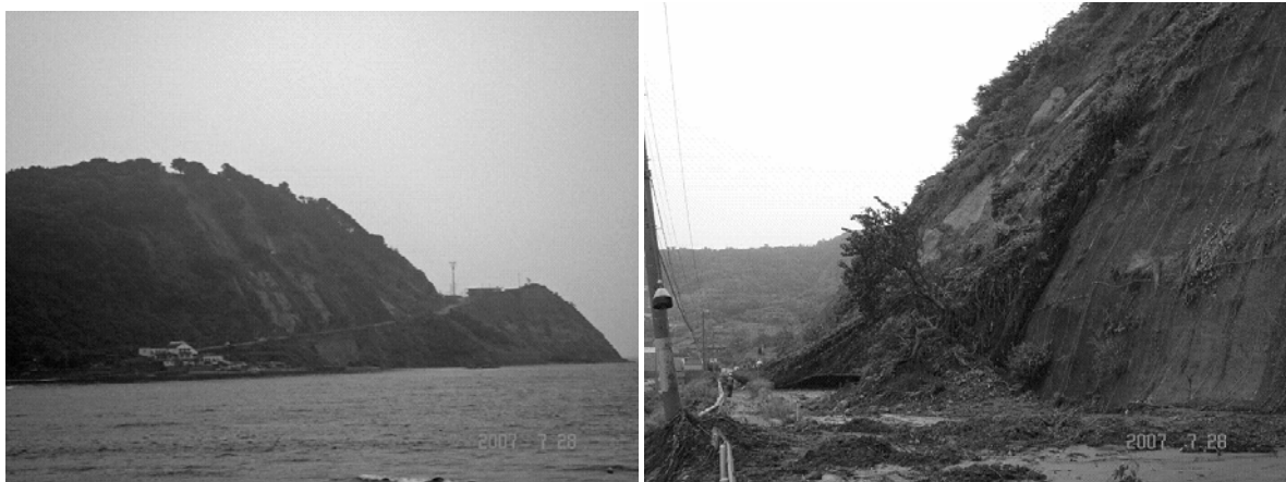
図-6 通行止めとなった国道352号線柏崎市椎谷-大崎区間(2007/7/28撮影)
